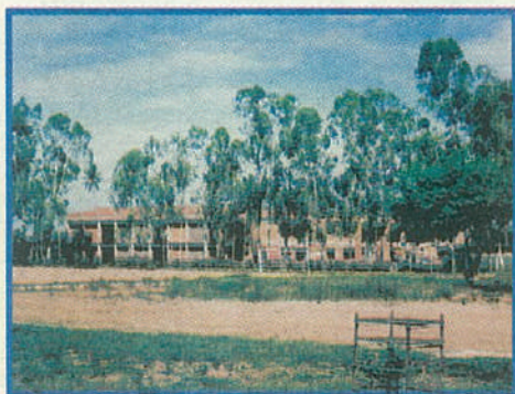
Obras em Santo Antônio de Jesus
